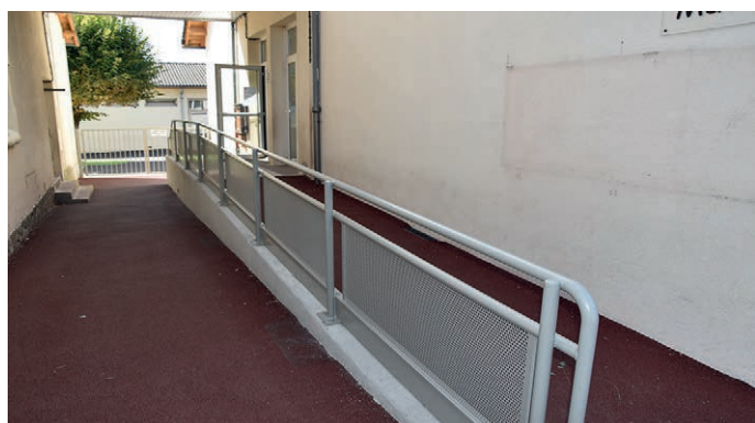
Accessibilité du bâtiment de direction de la maternelle. Rampe réalisée par les services techniques
