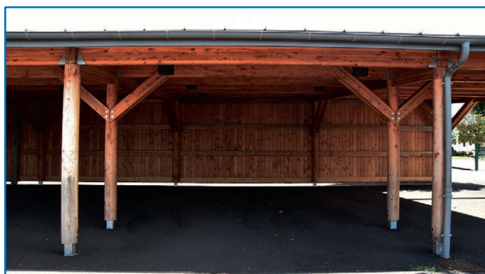
Réalisation de la fermeture du préau par les services techniques
